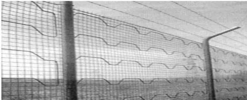
*Рис. Сенсорный кабель системы PPS2, смонтированный на сетчатой ограде.*
